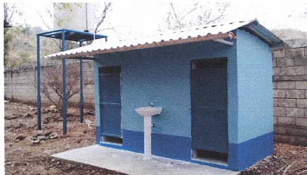
SANITARIOS: Finalización de mantenimiento de estructura de techo, lámina, puertas, inodoro y lavamanos.
