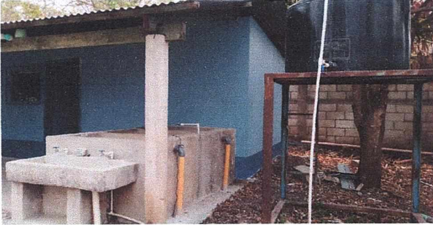
DRENAJE: Finalización de mantenimiento de sistema de drenaje y agua potable.
