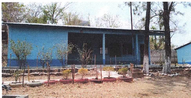
PINTURA: Finalización de pintura en exteriores e interiores.
