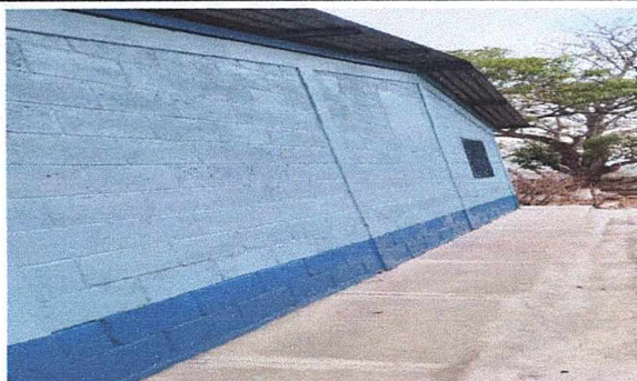
CUNETETA: Finalización de mantenimiento de cuneta.
