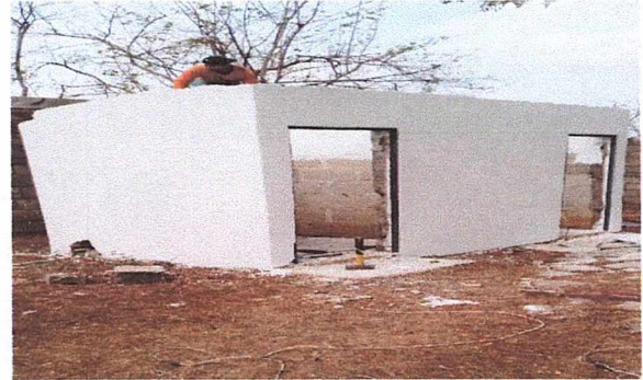
SANITARIOS: Mantenimiento de estructura de techo y mantenimiento de lámina, puerta, inodoros y lavamanos.
