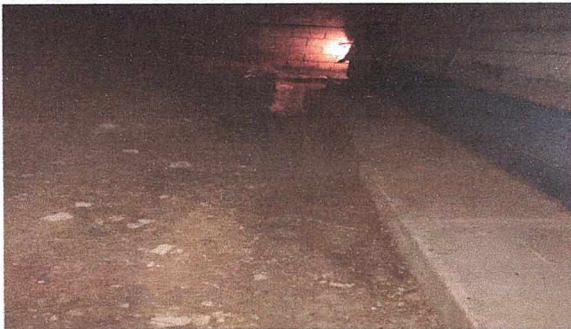
CUNETA: Mantenimiento de cuneta para salida de agua
