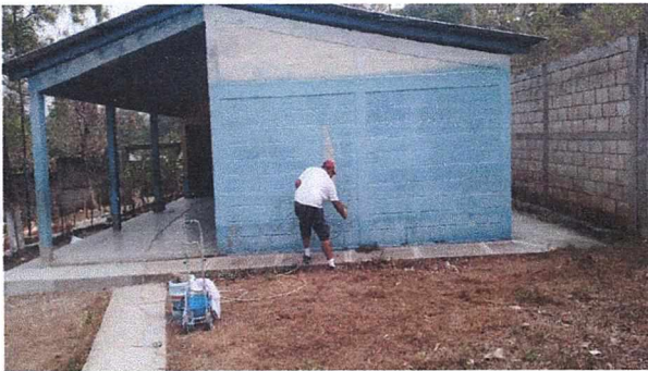
PINTURA: Mantenimiento de pintura en exteriores e interiores.
