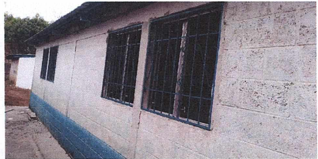
ILUMINACIÓN: Mantenimiento de ventanas con balcon en aulas
