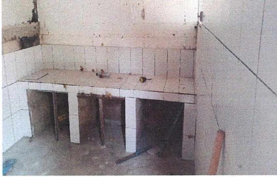
COCINA: Mantenimiento de repello, azulejo, piso y ventana.
