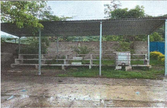
Finalización de techado de gradas
