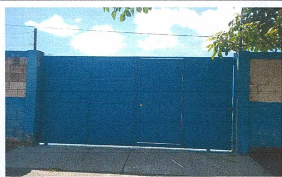
Finalización de porton
