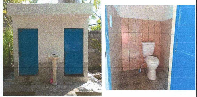
Finalización de región de servicio sanitarios y sus accesorios
