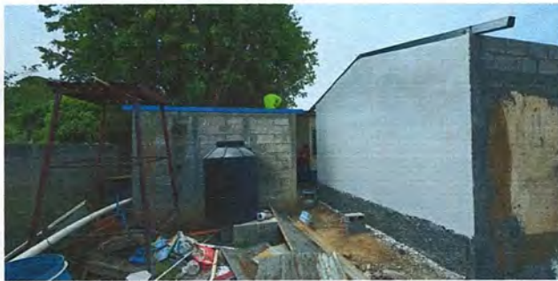
Proceso de instalación de estructura metálica, lámina y cambio de depósito de agua.
