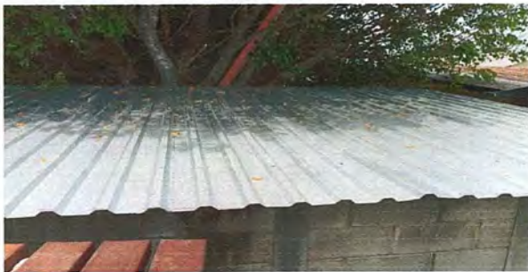
Proceso de instalación de lámina.
