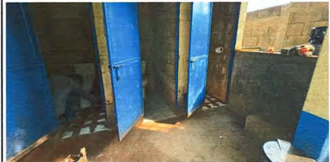
Proceso de instalación de piso cerámico e inodoro.
