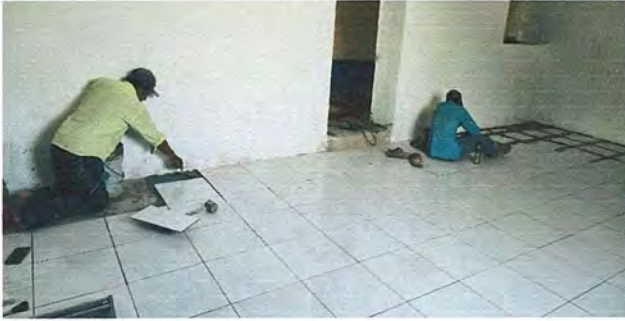
Proceso de instalación de piso cerámico.
