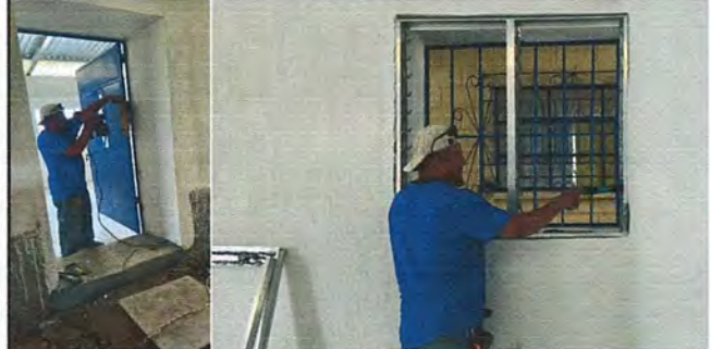
Proceso de instalación de puertas y ventanas.
