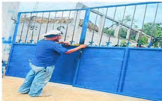
Proceso de arreglo de portón.
