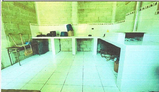
Finalizacion mejoramiento de cocina
