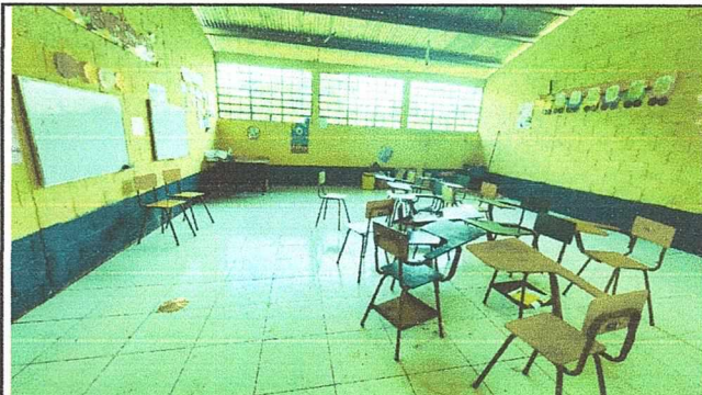
Finalizacion piso cerámico en aula
