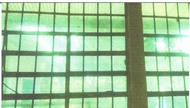
Finalizacion mejoramiento ventanas del aula
