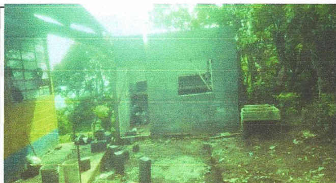
Mejoramiento de pared de cocina
