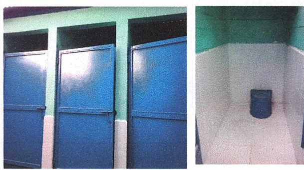
Resultado del remozamiento de puertas y cambio de letrinas en el servicio sanitario.
