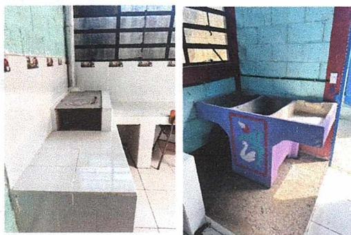
Resultado del remozamiento de cocina, pila y mantenimiento del sistema eléctrico.
