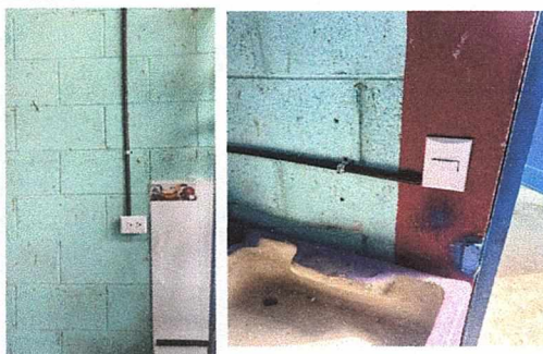
Sustitución y reparación del sistema eléctrico.
