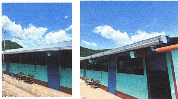
Resultado de la sustitución de lámina troquelada y sustitución de canal para agua pluvial.
