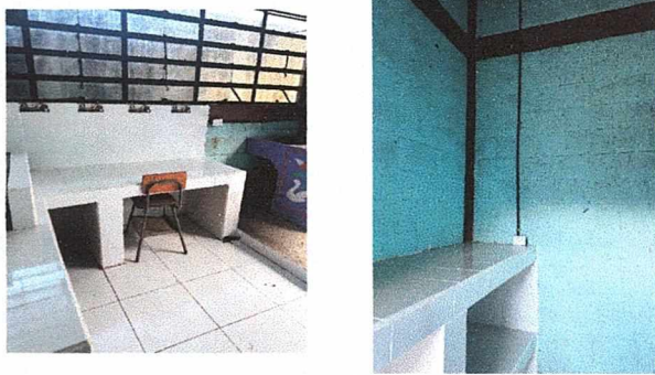
Finalización de remozamiento en mueble de cocina e instalación de azulejo en muebles, suelo y reparación del sistema eléctrico.
