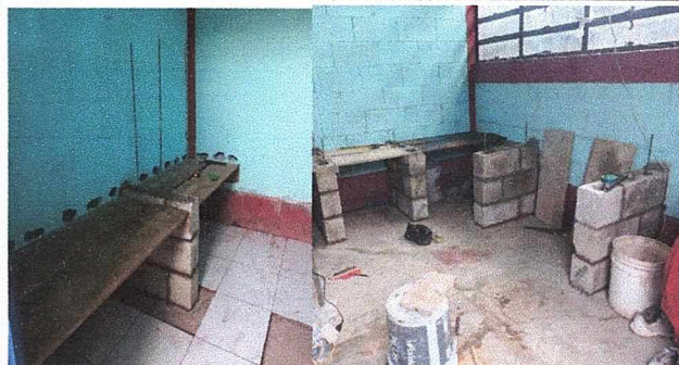
Mantenimiento de coicina, pizo, colocacion de estufa de leña.
