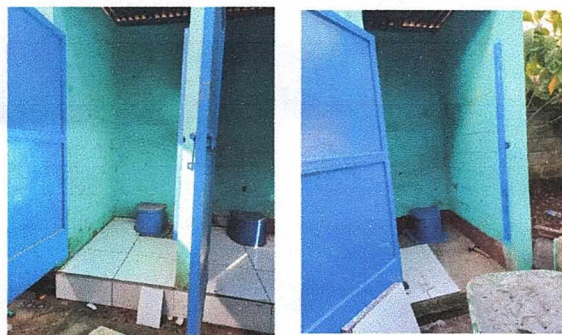
Mantenimiento de pizo, cambio de azulejo y cambio de letrina en el area de baños, mantenimiento de puertas.
