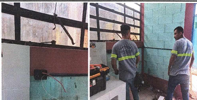
Momento en el que se realizo el mantenimiento en el sistema electrico en las areas planificadas.
