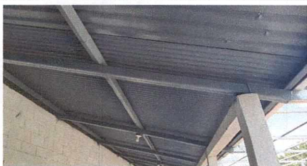
FINALIZACIÓN DE PINTURA EN TECHO Y ESTRUCTURA METÁLICA
