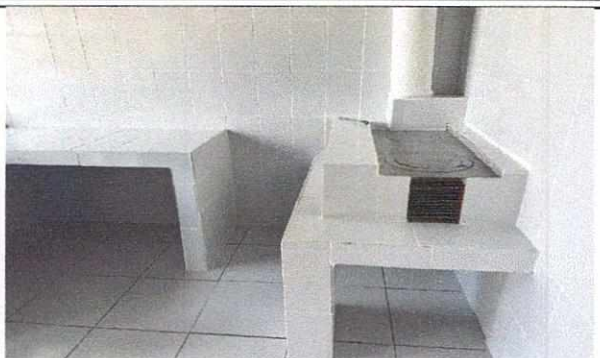
FINALIZACIÓN DE ESTUFA RURAL Y SU CHIMENEA
