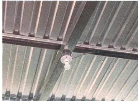
SUSTITUCIÓN DE FOCOS AHORRADORES
