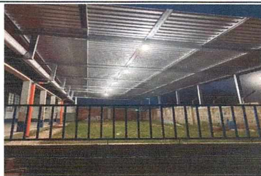
FINALIZACIÓN DE GALERA EN PATIO
