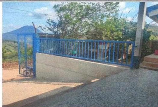
FINALIZACIÓN MANTENIMIENTO DE MURO Y SU BARANDA
