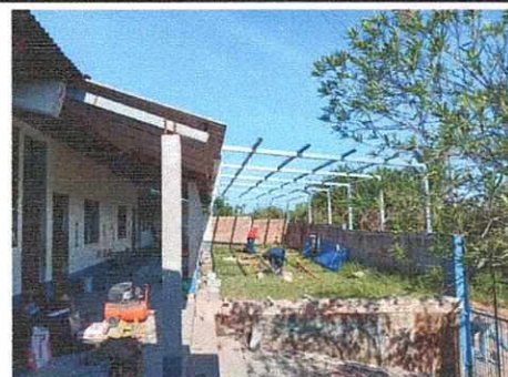
INSTALACIÓN DE TECHO EN GALERA
