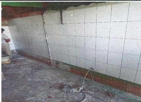
COLOCACIÓN DE AZULEJO EN PARED DE COCINA
