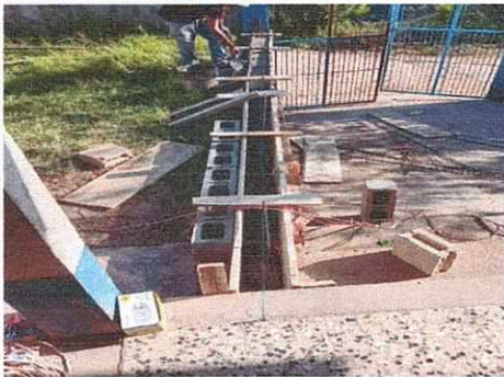
MANTENIMIENTO DE MURO
