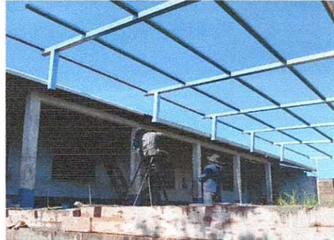
INTALACIÓN DE ESTRUCTURA EN GALERA
