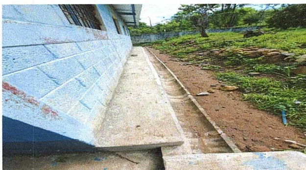
FOTO 3. REMOZAMIENTO DE CUNETA EN LA PARTE DE ATRÁS DE LAS AULAS
