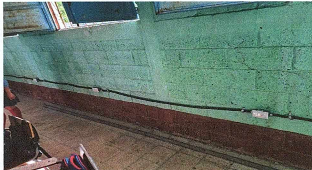
FOTO 2. INSTALACION DE TOMACORRIENTES
