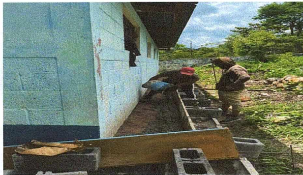
FOTO 3. REMOZAMIENTO DE CUNETA EN LA PARTE DE ATRÁS DE LAS AULAS
