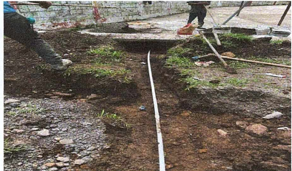
FOTO 2. REMOZAMIENTO DE TUBERIA DE DRENAJE PARA AGUA PLUBIAL CON SALIDA A LA CALLE
