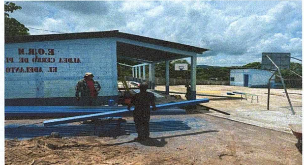
FOTO 6. ESTRUCTURA DE MADERA EN MAL ESTADO, SE SUSTITUIRA POR ESTRUCTURA DE METAL DE LA BODEGA Y 1 AULA
