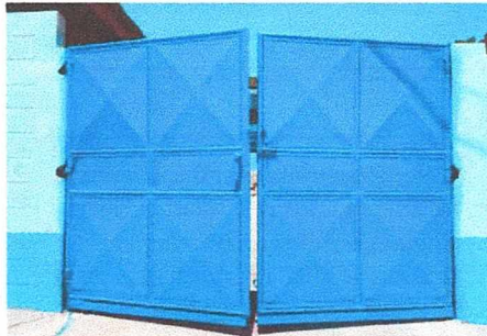
Reparacion de porton
