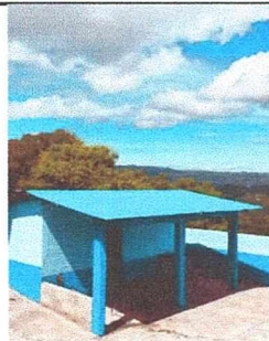
Refuerzo de techo exterior en cocina
