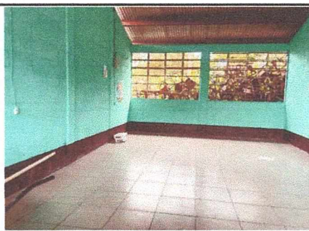
Instalacion de Piso ceramico en aulas
