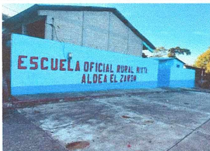
Levantado de block por seguridad de la Escuela
