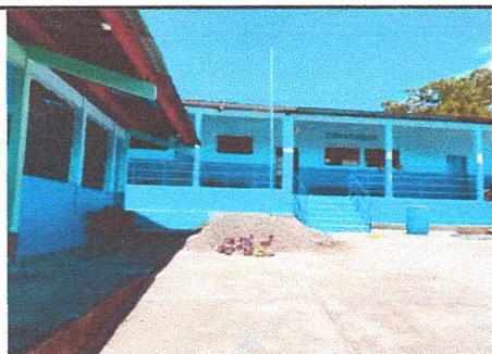
Instalacion de baranda por seguridad de los niños
