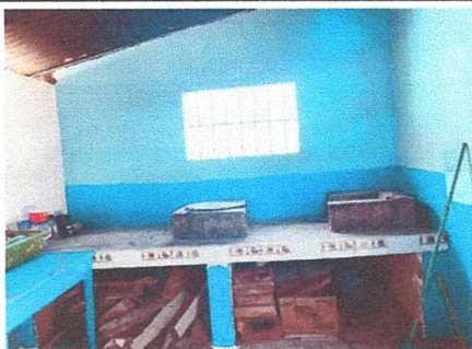
Instalacion de balcon en cocina
