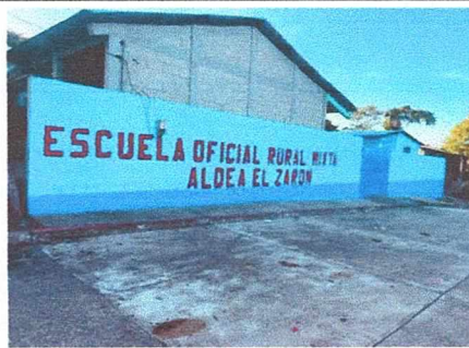
Pintura en Exterior de Escuela
