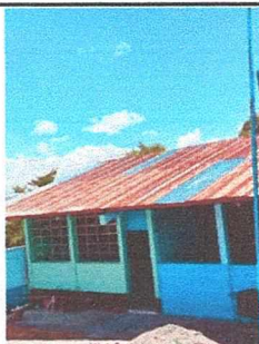
Reparacion de laminas en aulas
