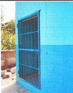
Instalacion de baranda para seguridad para equipo de computo
