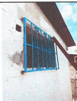
Instalación de balcon en cocina
