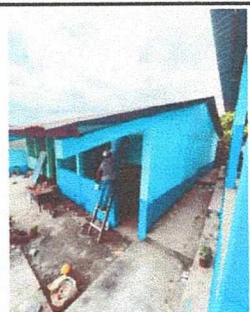
Pintura en fachada de aulas, baño y cocina
