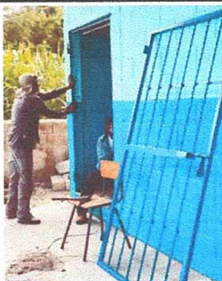
Instalación de baranda para seguridad para equipo de computo
