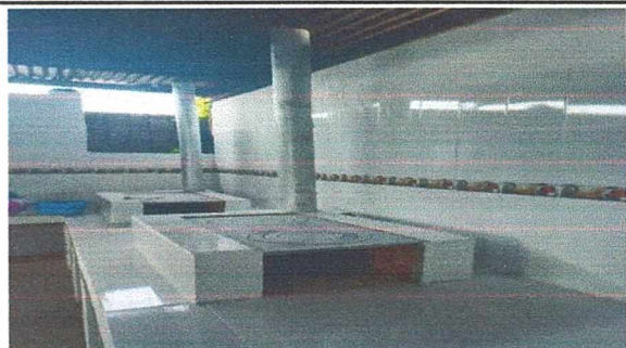
REPARACION DE COCINA
