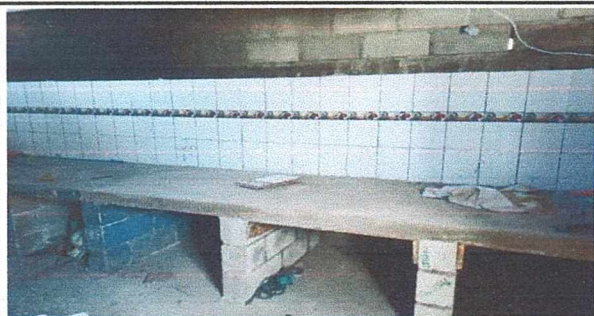
REPARACION DE COCINA
