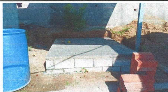
ELABORACION DE BASE E INSTALACION DE TINACO YA EXISTENTE
