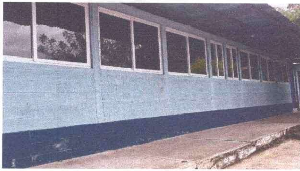
DESPUES REMOSAMIENTO DE VENTANAS DE PVC
