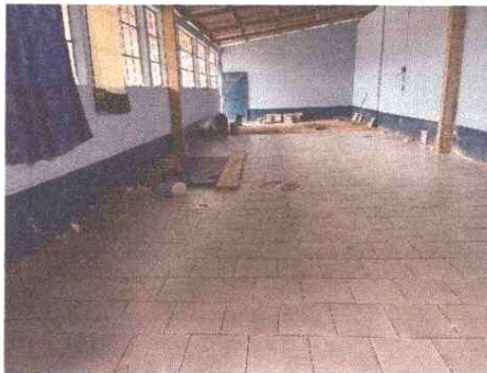
DESPUES INSTALACION DE PISO CERAMICO
