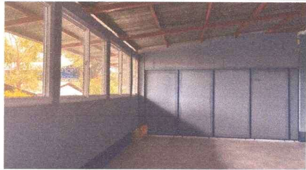
DESPUES DIVISION DE PARED DE TABLA YESO
