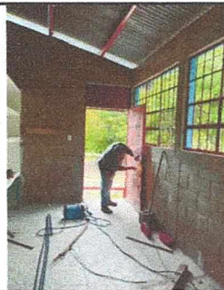
REMOZAMIENTO DE PUERTA MAS CHAPA
