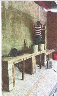
EDIFICACION DE MUEBLE DE COCINA DE CONCRETO
