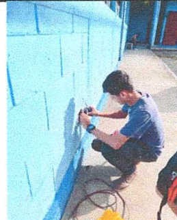
INSTALACION DE TOMACORRIENTES, PLAFONERAS Y FOCOS
