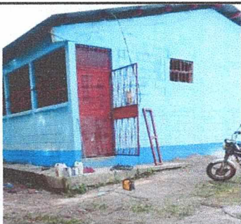
REMOZAMIENTO DE PUERTA TIPO BALCON
