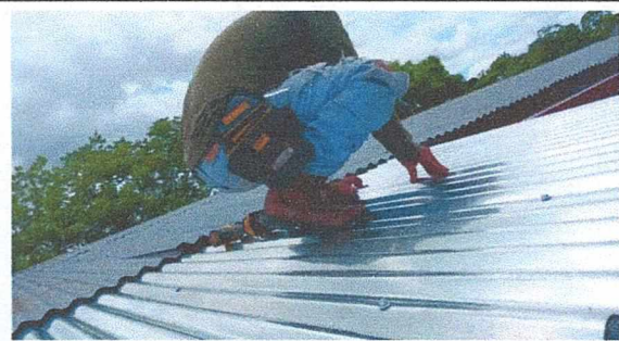
SUSTITUCION DE LAMINA ACANALADO ALUZINC CALIBRE 26
