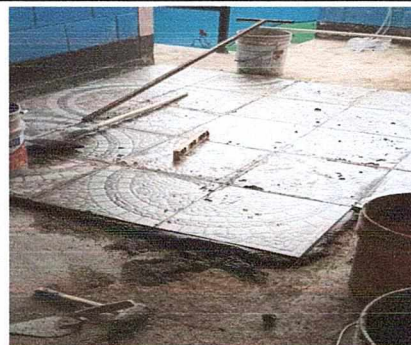
TORTA DE CEMENTO DEL PATIO EN MAL ESTADO
