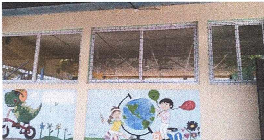
Foto 5: reparación de ventanas
