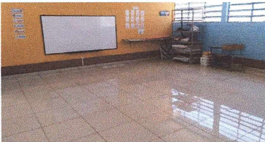
Foto 3: Reparación de piso
