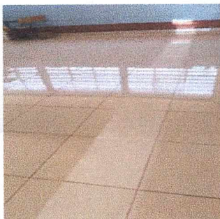
Foto 3: Reparación de piso
