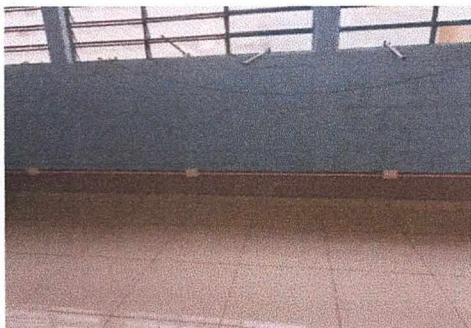
Foto 1: reparación sistema eléctrico
