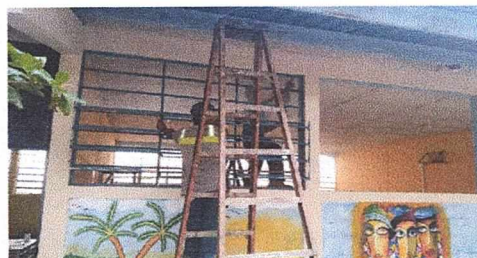
Foto 6: reparación de ventana
