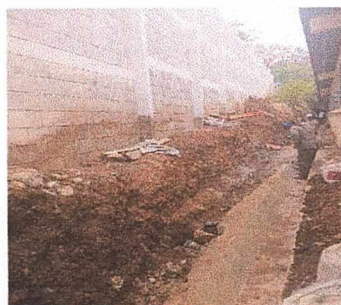
Foto 4: Reparación de muro
