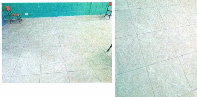
AULA, INSTALACIÓN DE PISO CERÁMICO
