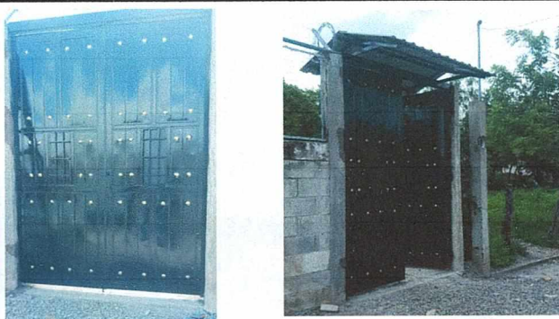
PORTÓN, SUSTITUCIÓN DE PORTÓN PRINCIPAL
