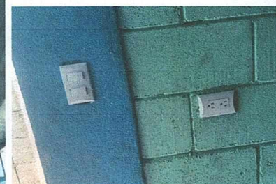
INSTALACIÓN ELÉCTRICA, REPARACION DEL SISTEMA ELÉCTRICO (CABLEADO, TOMAS, APAGADORES Y LUMINARIAS)
