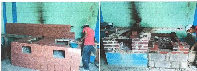
COCINA, SUSTITUCIÓN DE PLANCHA, CHIMENEA, PILA
