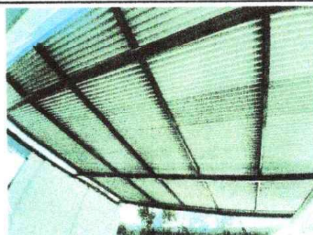
Foto 6: Cubierta área de comedor
