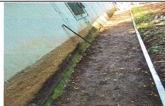
PREPARANDO DONDE SE HARÁ LA CUNETA DE CEMENTO
