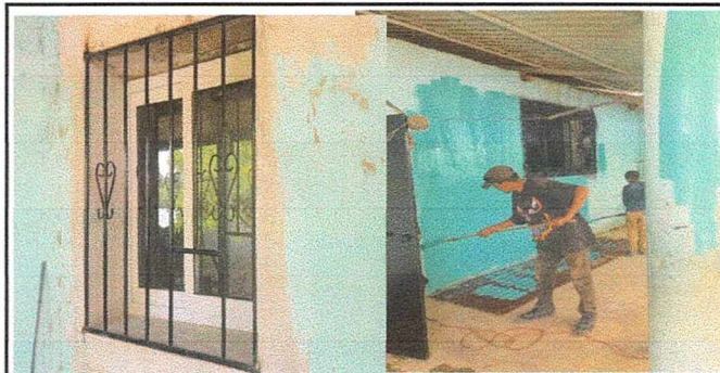
DURANTE SE PINTABA LA PARTE EXTERIOR DE LAS AULAS Y COCINA
