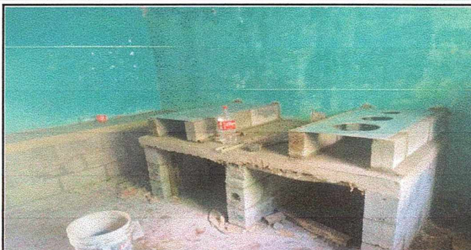
SE ESTÁ LEVANTANDO LA COCINA CON DOS PLANCHAS CON CHIMENEA
