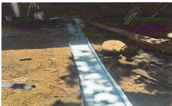
PREPARANDO EL CANAL Y BAJADAS DE AGUA PLUVIAL
