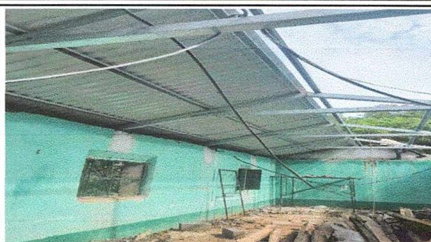
SE ESTÁN CAMBIANDO LAS LÁMINAS EN MAL ESTADO, POR LÁMINAS NUEVAS Y DE IGUAL MANERA LOS CUARTONES, VIGAS, Y COSTANERA
