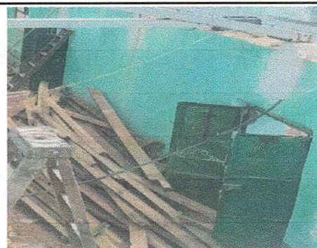
SE QUITARON LAS PUERTAS EN MAL ESTADO
