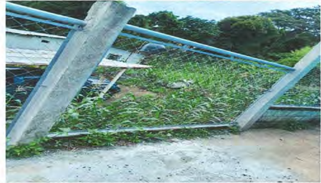
CAMBIO DE MALLA METÁLICA POR DETERIORO
