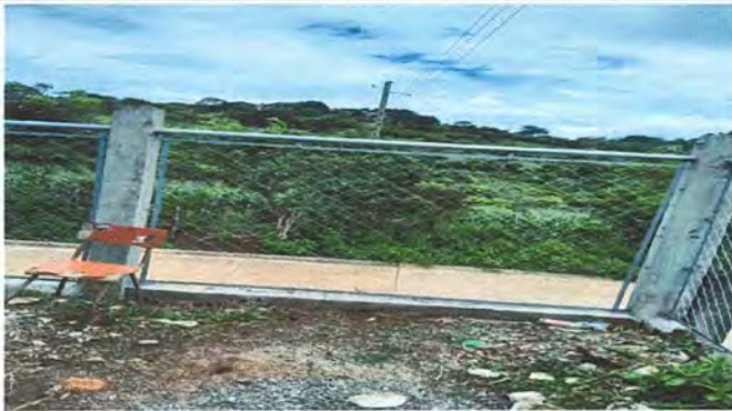
CAMBIO DE MALLA METÁLICA POR DETERIORO
