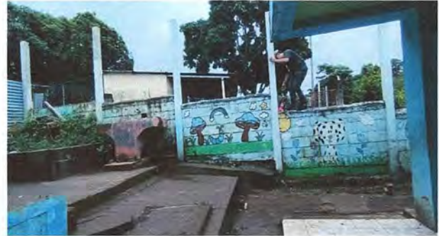
CAMBIO DE MALLA METÁLICA POR DETERIORO
