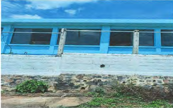
CAMBIO DE MALLA METÁLICA POR DETERIORO
