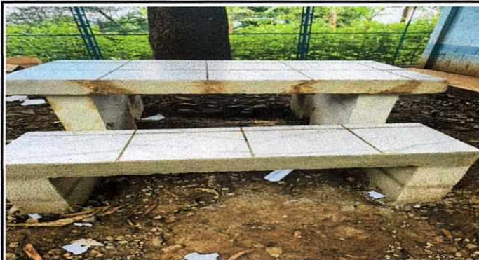
Foto 1: Terminación de construcción de mesas en el exterior del establecimiento.
