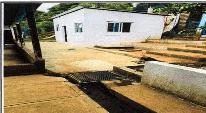
Foto 3: Terminación de remodelación del área externa de la cocina y entortado del patio.
