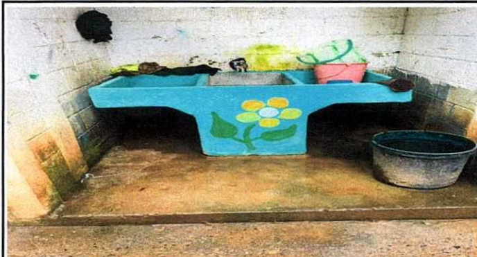
Foto 2: Terminación del área de baños remodelada.
