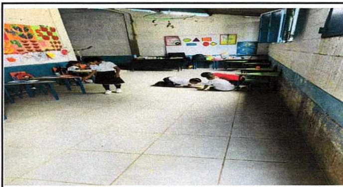
Foto 4: Terminación de la colocación de piso en el aula.
