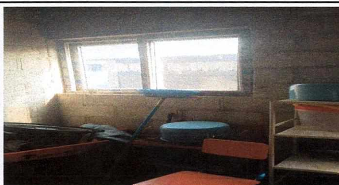
Foto 3: Área de cocina sin remodelar.
