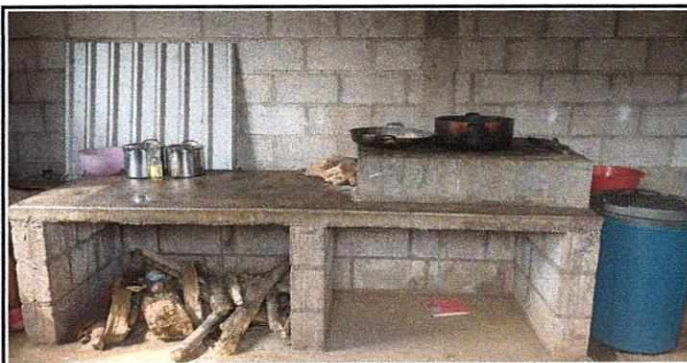
Foto 6: área donde se construirá una mesa sin remodelar
