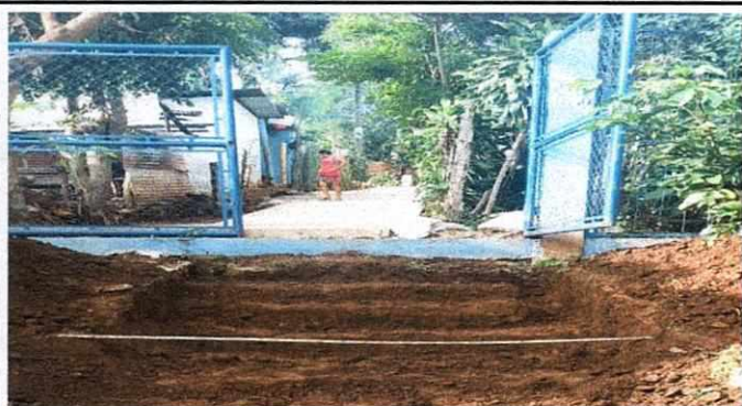
Foto 1: Área de ingreso al establecimiento
