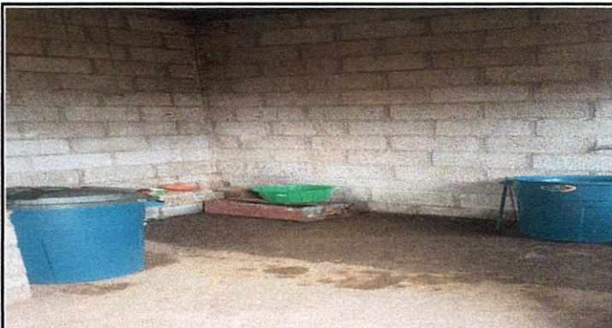
Foto 4: área de cocina donde se construirá una chimenea y un polleton.
