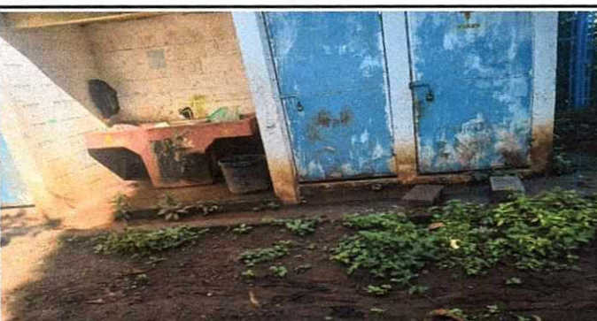
Foto 5: Baños y pila sin remodelar
