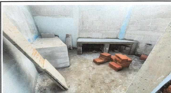
Foto 3: Realización de muebles de cocina de concreto para colocación de estufa rural y almacenar utensilios de cocina para la preparación de alimentos.
