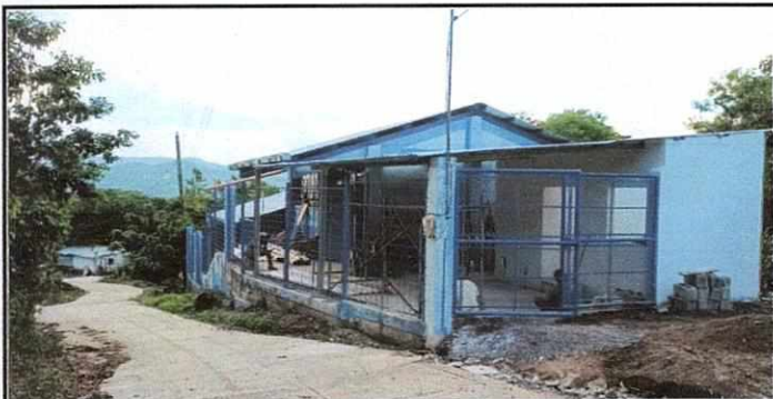
Foto 5: Colocación de estructura metálica y lamina para el área de cocina, patio y baños.
