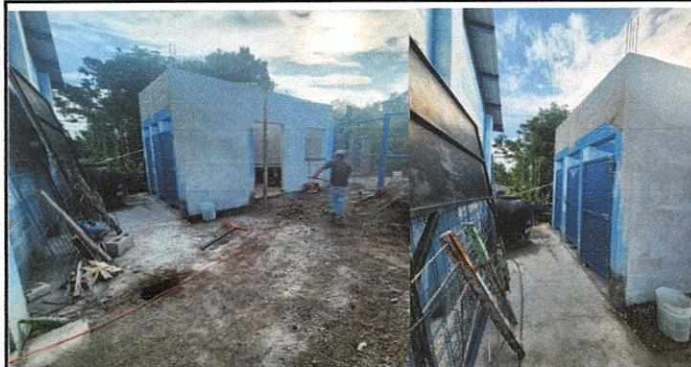
Foto 2: Levantado de block para nivelación de paredes de baños para remozamiento de cocina.
