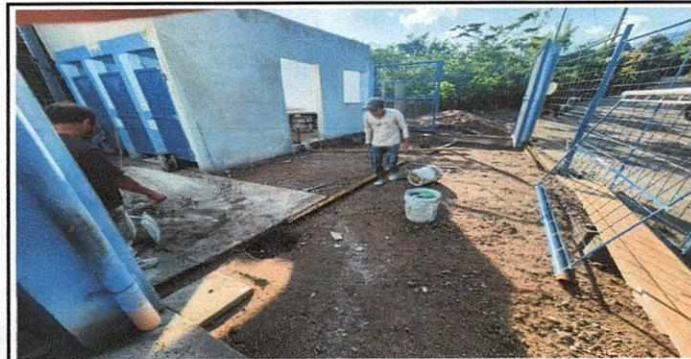
Foto 6: Preparación del terreno, relleno y compactación con material selecto para la pavimentación con concreto.
