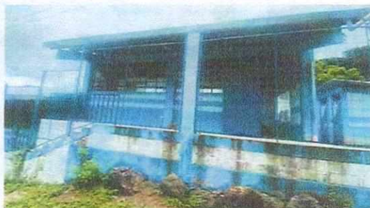
Foto 5: Pintura en muros en mal estado, se limpiará el área de trabajo y se aplicarán 2 manos de pintura látex antihongos.
