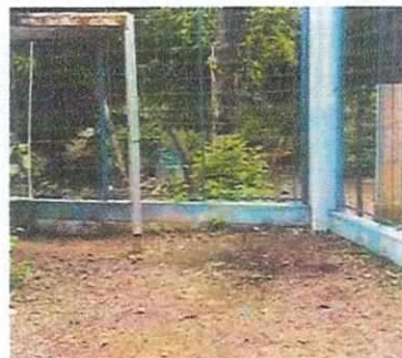
Foto 2: Área de cocina sin piso, muros no alcanzan el techo.
