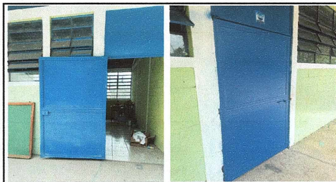
Foto 4: Terminación de la colocación de puertas nuevas.
