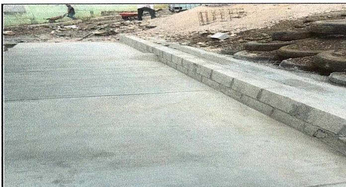
Foto 3: Terminación del entortado de la entrada al establecimiento.
