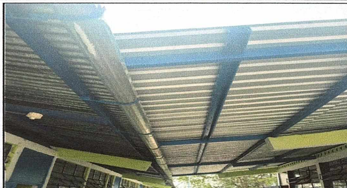
Foto 2: Terminación de techado.
