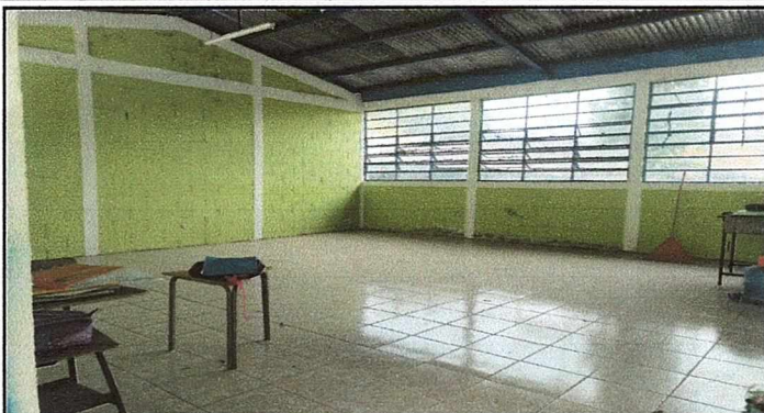
Foto1: Terminación de colocación de piso cerámico
