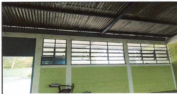
Foto 6: Terminación de cambio de algunas laminas dañadas.
