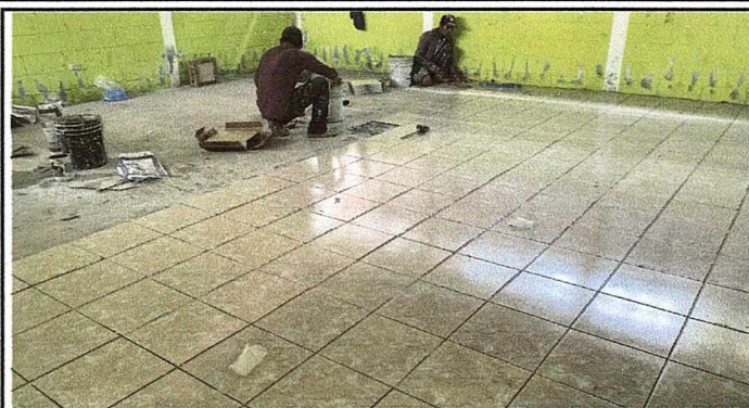
Foto 2: En proceso de colocación del piso cerámico
