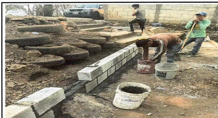
Foto 3: Inicio del arreglo de la entrada del establecimiento
