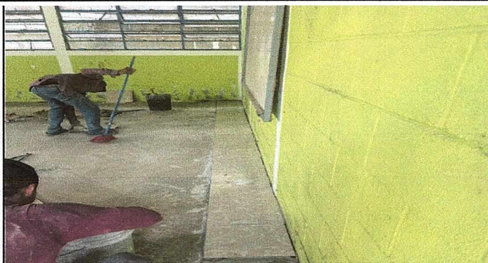
Foto1: Inicio de colocación de piso cerámico
