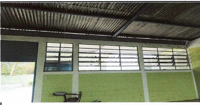
Foto 6: Imágenes del proceso de reparación del techo.
