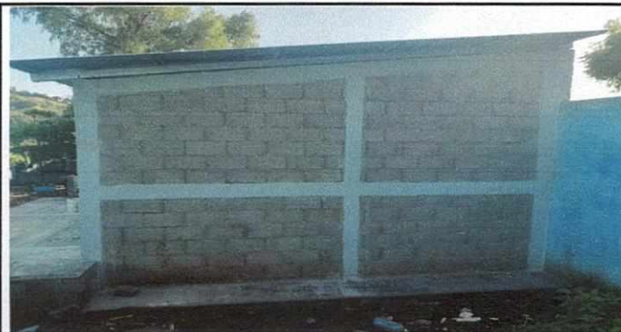
Foto 3: Aula ya ampleada y remodelada
