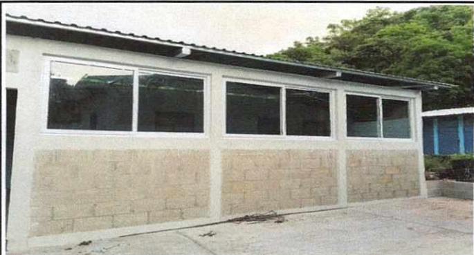
Foto1: Aula ya ampleada y remodelada
