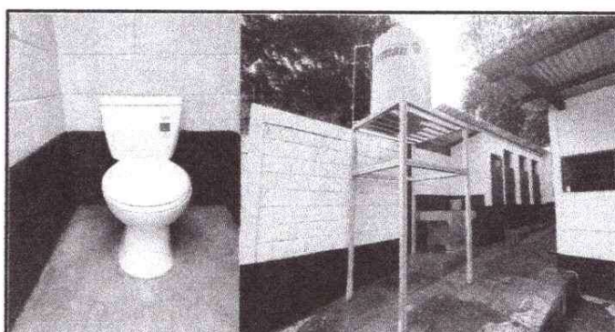
Foto 4: Artefacto sanitario para niños, puerta para baño, sustitución de sanitarios, cubierta de lamina troquelada calibre 26, pila en módulo de sanitario, estructura metálica para tinaco.
