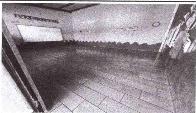
Foto 1: Instalación de piso cerámico terminado.
