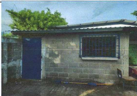
Foto 1: Cocina completa, techo, puerta y balcon instalados.
