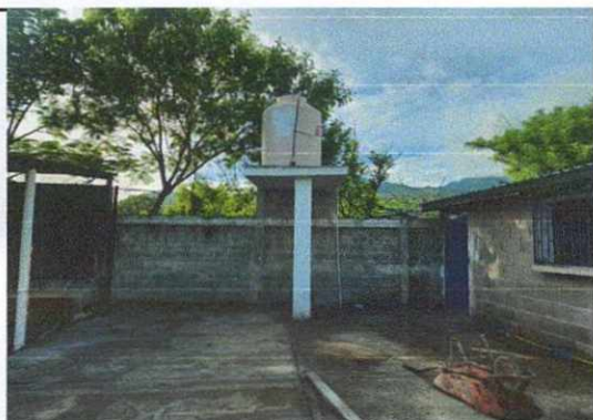
Foto 3: Patio frente a cocina completado y reubicacion de tinaco
