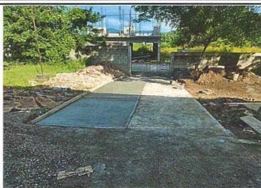
Foto 2: Planchas de concreto reparadas en la entrada de la escuela, banca de concreto
