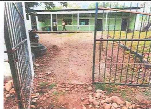
Foto 3: Rampa de ingreso a pavimentar.
