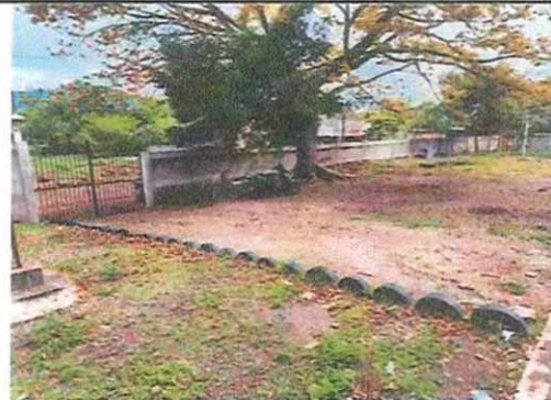
Foto 4: Construcción de banca para descanso de recreo.
