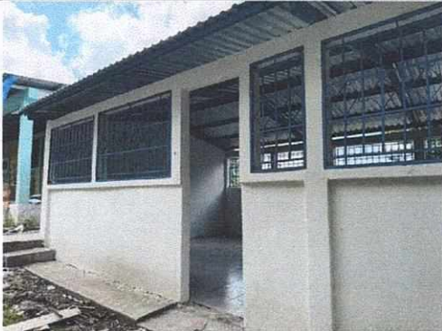
Foto1: Módulo de aula finalizado: refuerzo en muros, mantenimiento de estructura, estructura nueva, cubierta de lámina troquelada, contrapiso, banqueta, repello y cernido en muros.
