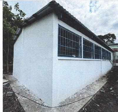
Foto 2: Modulo de aula finalizado: refuerzo en muros, mantenimiento de estructura, estructura nueva, cubierta de lámina troquelada, contrapiso, banqueta, repello y cernido en muros.
