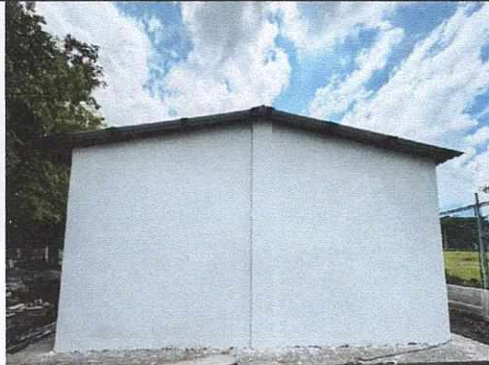
Foto 3: Módulo de aula finalizado: refuerzo en muros, mantenimiento de estructura, estructura nueva, cubierta de lámina troquelada, contrapiso, banqueta, repello y cernido en muros.
