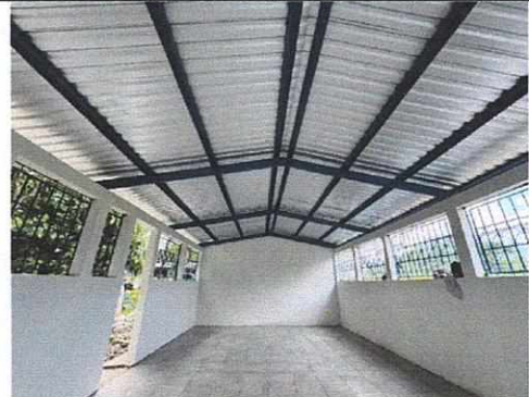
Foto 4: Modulo de aula finalizado: refuerzo en muros, mantenimiento de estructura, estructura nueva, cubierta de lámina troquelada, contrapiso, banqueta, repello y cernido en muros.
