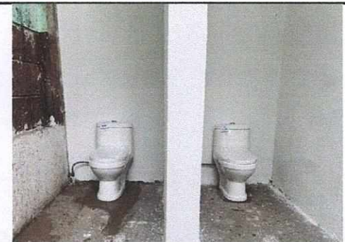
Foto 5: Módulo de sanitarios finalizado: muros, cubierta de lámina, contrapiso, artefactos sanitarios.
