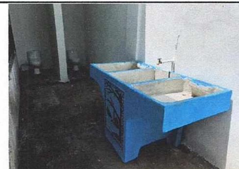
Foto 6: Módulo de sanitarios finalizado: muros, cubierta de lámina, contrapiso, artefactos sanitarios y pila.
