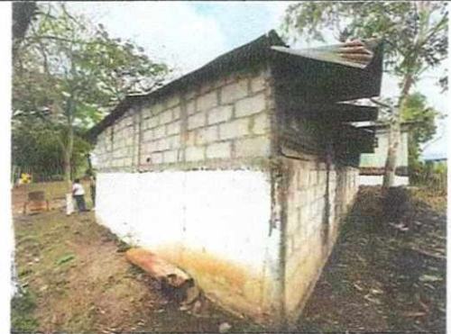
Foto 2: Módulo de aulas, repello en muros, fundicion de contrapiso y banqueta.
