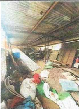
Foto 3: Modulo de aulas, sustitución de lámina deteriorada por lamina troquelada, mantenimiento a la estructura y reforzar con mas vigas y costaneras.
