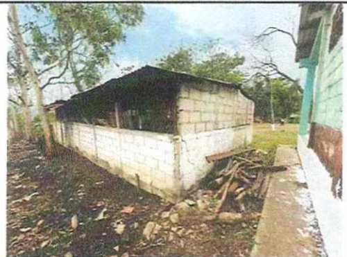
Foto 4: Módulo de servicios sanitarios, continuacion de levantado de muros, fundicion de contrapiso, instalaciones sanitarias e instalación de cubierta de lámina troquelada.
