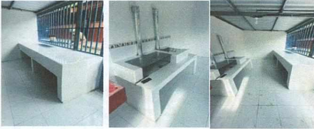
Foto1: Cocina se hizo un remozamiento de mesa de concreto, se hizo el poyotón con plancha de cocina + chimenea, se colocó azulejo en estufa y paredes, y el remozamiento de la puerta.
