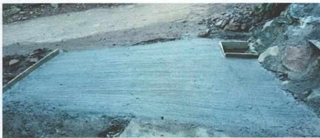
Foto 5: Área de entrada se colocó tubo de drenaje de pila de otra casa con su caja y fundición de entrada nueva con electromalla de reforzamiento.
