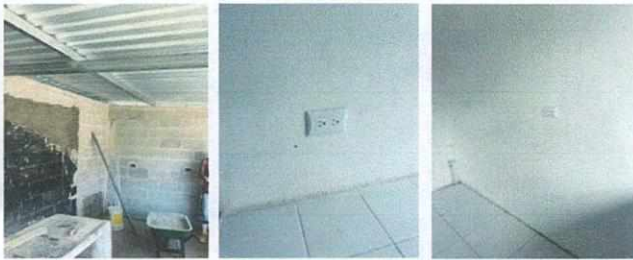
Foto 3: Instalación eléctrica completa y colocación de techo con su estructura.
