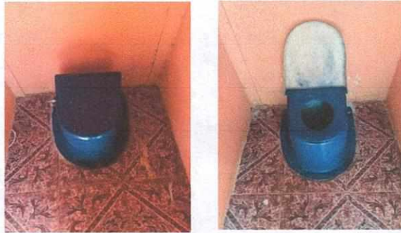
Foto 4: Colocación de nuevos inodoros de fibra de vidrio para niños y niñas en pozo ciego.
