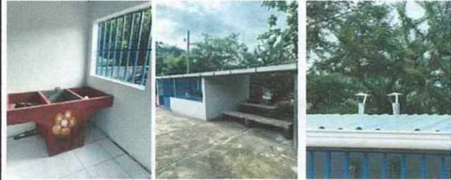
Foto 2: Área de cocina se colocó pila de dos lavaderos, repello en paredes, colocación de lámina troquelada calibre 26 con estructura metálica y chimeneas en estufa.
