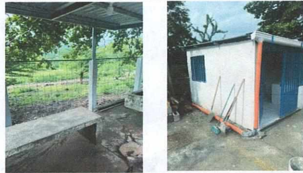
Foto 6: Área de Patio se colocó en muro perimetral electromalla para proteger con arreglo de columnas nuevas fundidas con hierro de 3/8" y repellos en parte lateral de cocina con su bajada de agua pluvial.
