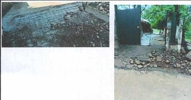
Foto 3: Reconstrucción de entrada principal con plancha de concreto reforzada.
