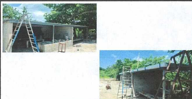
Foto 6: colocación de lamina troquelada calibre 26 con estructura metálica con su canal PVC de agua pluvial.
