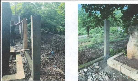
Foto 4: Área de Patio se colocará en muro perimetral electromalla para proteger con arreglo de columnas nuevas fundidas con hierro de 3/8".
