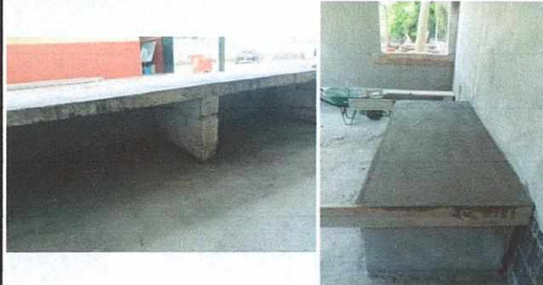
Foto 2: Área de cocina se reconstruyó las planchas y se le colocaron azulejo en todo, repello en paredes.
