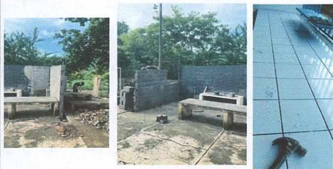
Foto 1: Cocina se hizo un remozamiento de mesa de concreto, se hizo el poyotón con plancha de cocina + chimenea, se colocó azulejo en estufa y paredes.
