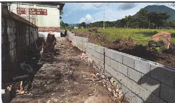
Foto 5: Muro perimetral conformado por: cimentación, levantado de block, fundición de solera de humedad, levantado de block, y fundición de solera U.
