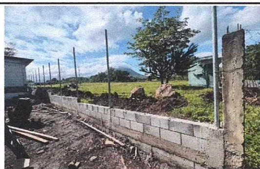
Foto 6: Fundición de postes galvanizados de 2 pulgadas de diametro 2.40 m. de altura.
