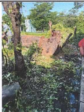
Foto 1: Chapeo y destronque en cerco perimetral.
