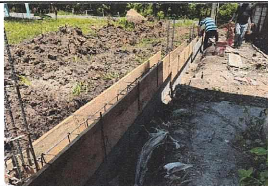
Foto 4: Fundición de solera 0.15x0.20 m. armada con 4 hierros de 3/8" estribos de 1/4" a cada 0.20 m.
