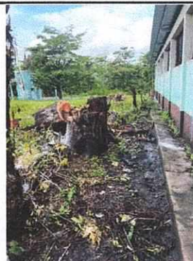
Foto 2: Chapeo y destronque en cerco perimetral.
