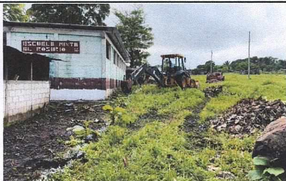
Foto 3: Zanjeo empleando retroexcavadora.
