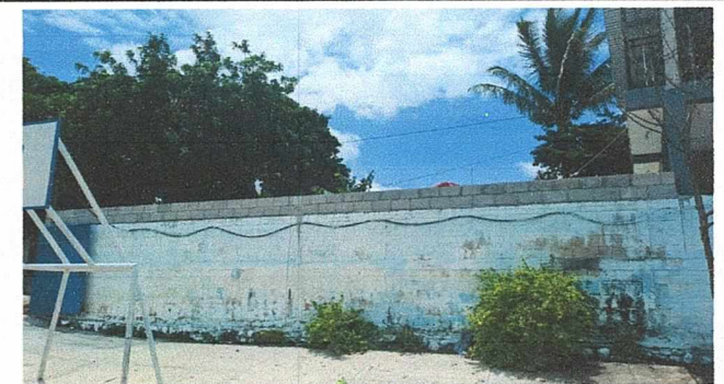
Foto 6: Remozamiento de muro perimetral finalizado
