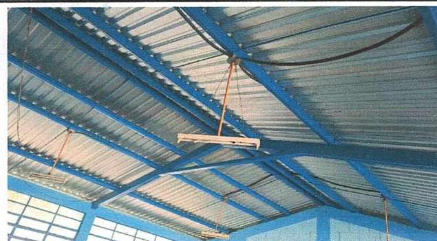
Foto 5: Cambio de techo bloque 2 finalizado
