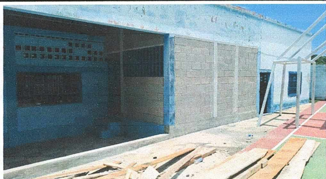
Foto 3: Bodega, puerta y ventana finalizada
