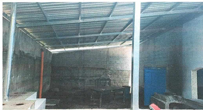
Foto 2: Poyeton con azulejo, chimenea, estructura, techo, canal y tubería plubial, puerta; finalizada.
