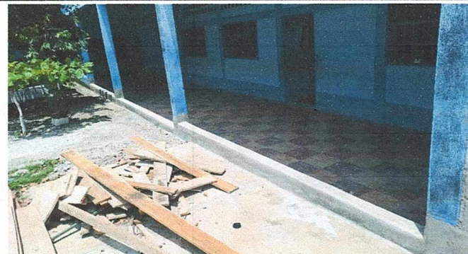
Foto 4: Remozamiento de solera finalizado
