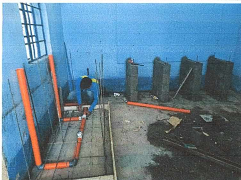
Foto1: Construcción de Pila y Mesa con Azulejo
