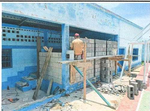
Foto 3: Construcción de bodega
