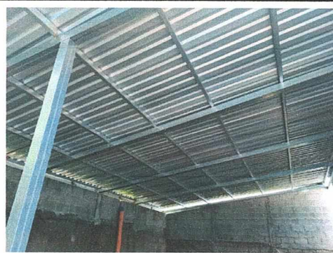
Foto 2: Cambio de estructura metalica, lamina, canal y tubería plubial
