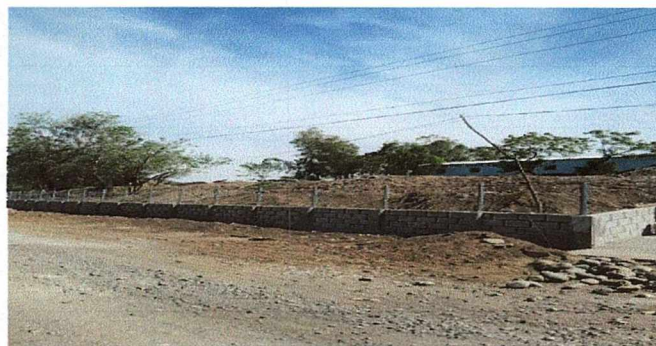
Foto 2: Construcción de muro perimetral
