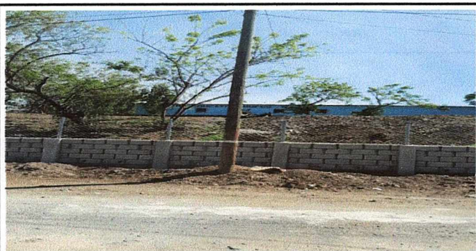
Foto 5: Construcción de muro perimetral
