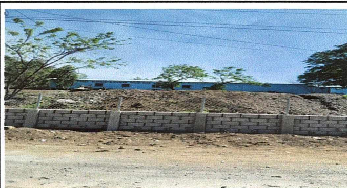
Foto 4: Construcción de muro perimetral
