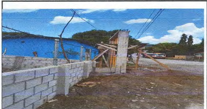
Foto 8: Construcción de muros para portón
