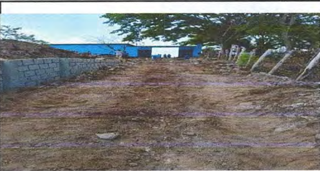
Foto 4: Nivelación del terreno
