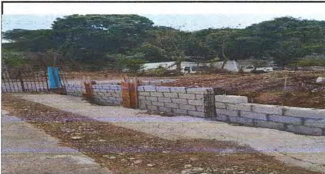
Foto 7: Levantado y fundición de muro perimetral
