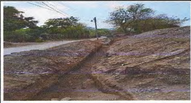
Foto 2: Zanqueo para cimiento
