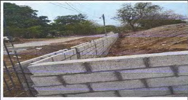
Foto 6: Levantado con block
