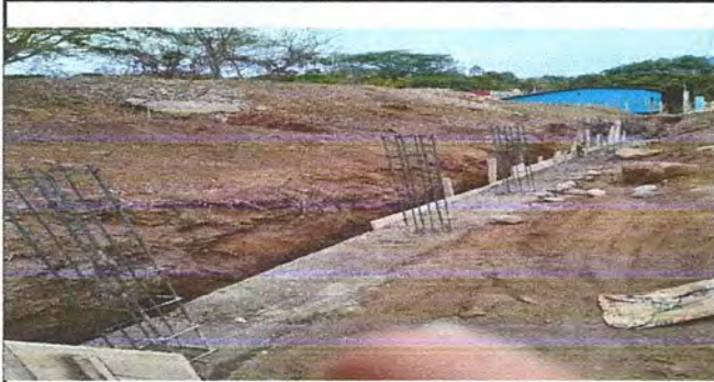
Foto 5: Cimiento para el muro perimetral
