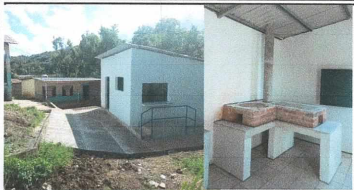
Foto1: Cocina: finalización de repello por dentro y por fuera, cocina rural.
