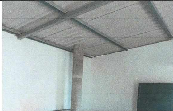
Foto 4: finalización de sustitución de lámina tipo troquelada
