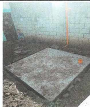
Foto 6: Fosa séptica Finalizada.
