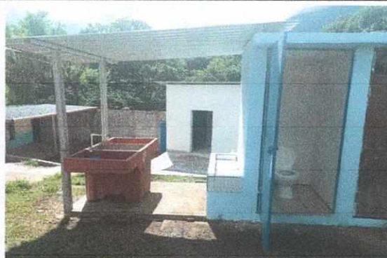
Foto 2: Sanitarios: Se instalo el ara mas de sanitario, una pila y lavamanos, se repararo el sistema del tinaco y agua potable
