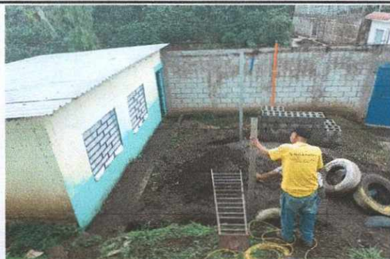
Foto 3: Proceso de construcción de un techo de estructura metálica, que proporcione sombra a este salón de clases
