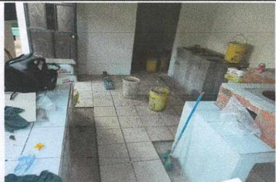
Foto 5: Proceso de instalación de piso cerámico en el interior de la cocina
