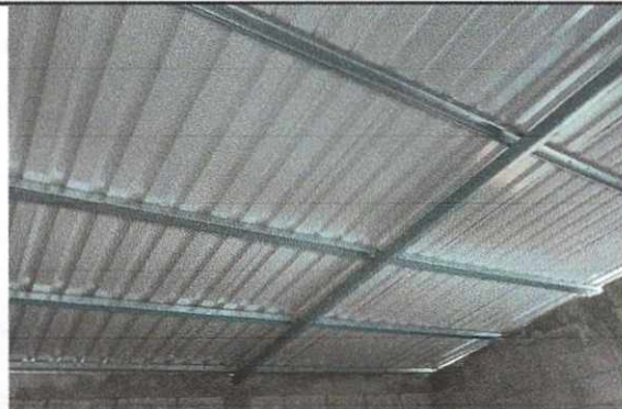
Foto 4: proceso de sustitución de lámina, por lámina tipo troquelada
