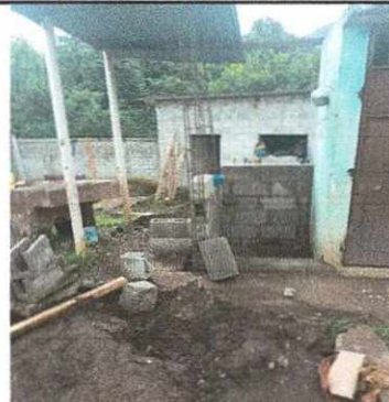
Foto 2: Sanitarios: proceso de un área mas, se agregará una pila y lavamanos, se reparará el sistema del tinaco y agua potable
