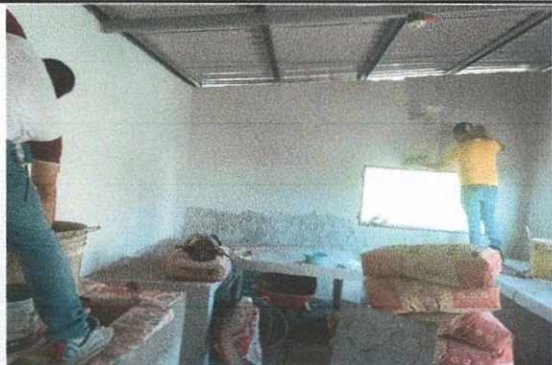
Foto1: Bodega de cocina: proceso de repello por dentro y por fuera, elaboración de cocina rural y mueble de concreto mas estantería para guardar alimentos
