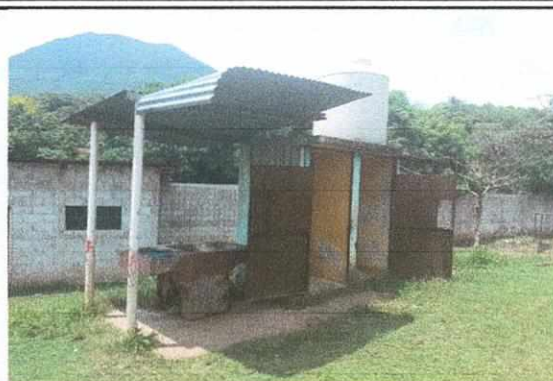
Foto 2: Sanitarios: se elaborará un área mas, se agregará una pila y lavamanos, se reparará el sistema del tinaco y agua potable
