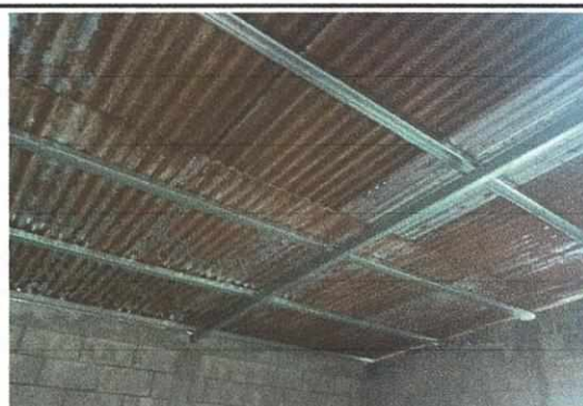
Foto 4: se sustituirá lámina, por lámina tipo troquelada
