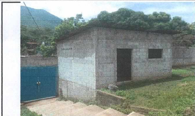
Foto1: Bodega de cocina re repellará por dentro y por fuera, se elaborara cocina rural y mueble de concreto mas estanteria para guardar alimentos
