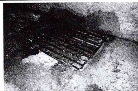
Foto 6: Sustitución de planchas de concreto
