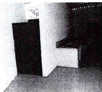
Foto 3: mejoramiento de muro de bodega
